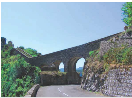
Curieux viaduc pour accéder à la chapelle ND de la Ménour à Moulinet
