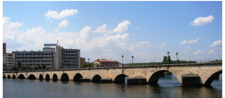
Pont romain de Mirandela long de 230 m sur la rivière Tua
