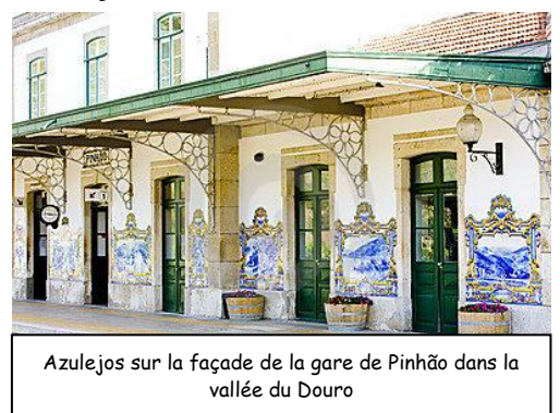
Azulejos sur la façade de la gare de Pinhão dans la vallée du Douro
