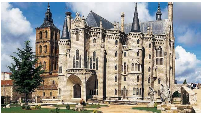
Vue du Palais Episcopal d'Astorga, terme de la 3 ème étape. C'est un édifice de style moderniste conçu entre 1889 et 1893 par l'architecte espagnol Antoni Gaudí. Il s'agit d'une des rares œuvres importantes de Gaudí hors de Catalogne.
