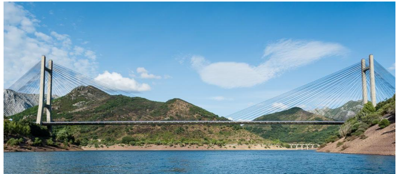
Très pont à haubans qui supporte l'autoroute AP-66 au dessus de l'Embalse de los Barrios de Luna
