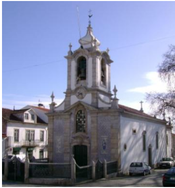
Eglise paroissiale d'Alijó avec sa façade décorée d'azulejos
