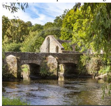
Pont St Jean à Pont-Scorff que les cyclistes de la VL vont emprunter.
