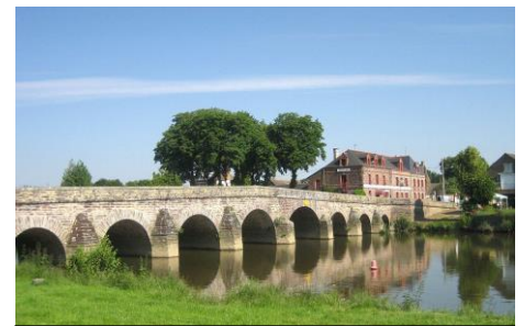
Le pont de Pont-Réan sur la Vilaine franchit après le repas
